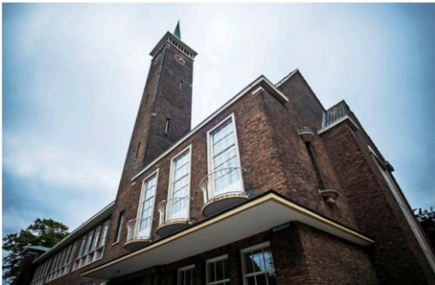
De toren, een kroon op het schoolgebouw aan de Bergerhout.
